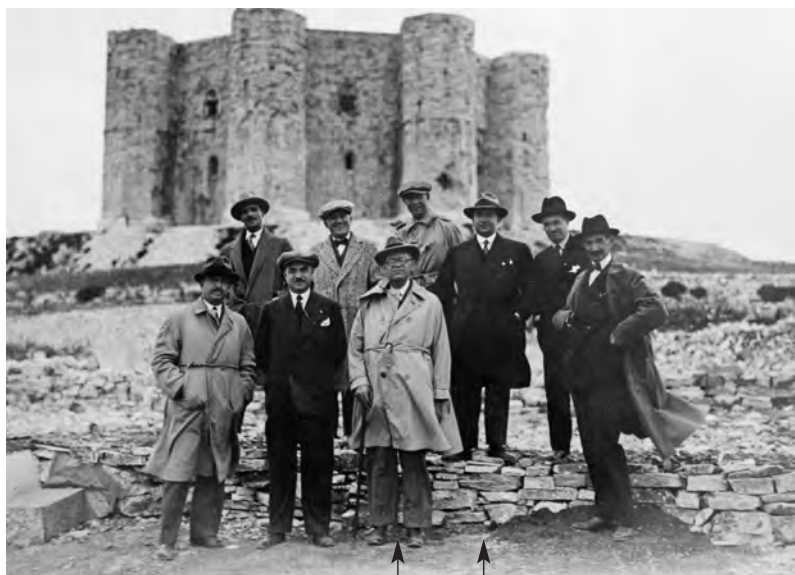
Ottobre 1929. L'ambasciatore Bernardo Attolico e Michele Viterbo, all'epoca Preside della Provincia, durante un sopralluogo ai restauri di Castel del Monte, fatti eseguire dalla Provincia. Fanno parte del gruppo il prefetto Cavalieri, il dott. D'Alonzo, il dott. Vella, il direttore della "Gazzetta del Mezzogiorno" Gorjux, e l'avv. Cafaro.
