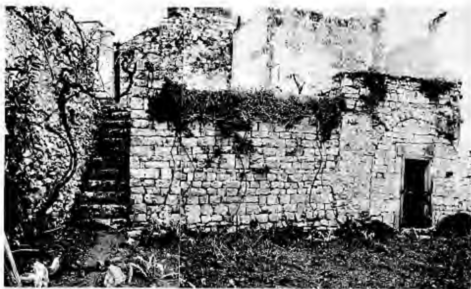
Castellana, interno della torre ovale.
