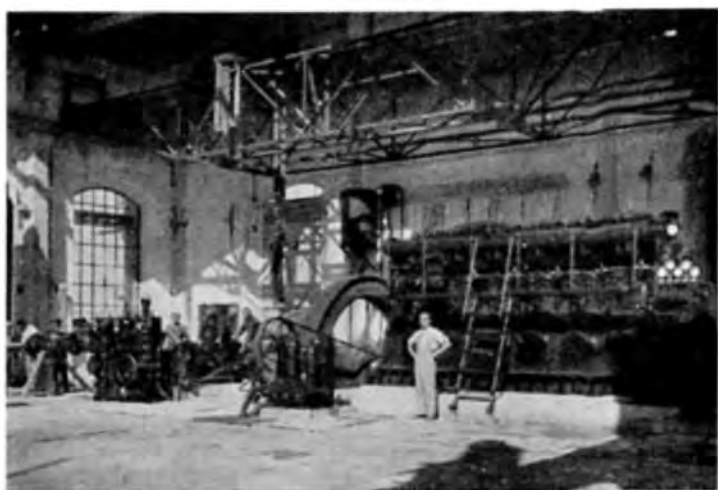
Macchinario per l'impianto di sollevamento di Monte S. Angelo (Foggia).
