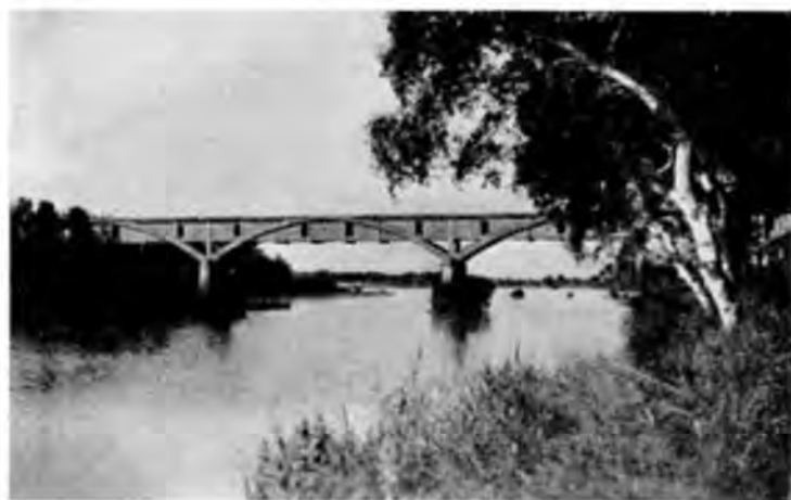
Ponte canale sull'Ofanto.
