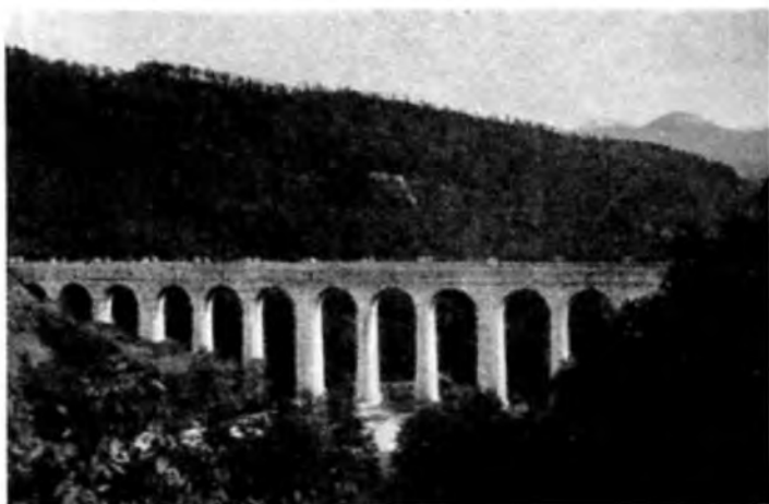
Ponte canale sul torrente Bradano (fiumara di Atella).
