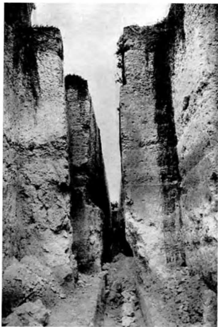
Scavo per la costruzione del serbatoio di Torre Canne.
