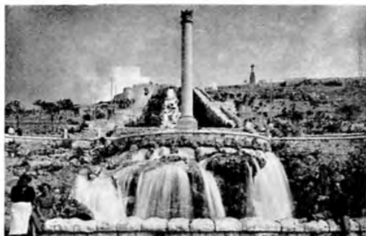
Colonna terminale dell'Acquedotto e fontana a S. Maria di Leuca. (Architetto Brunetti).
