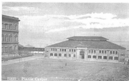
Il mercato in ferro al Corso Cavour (ove rimase dal 1881 al 1927).
